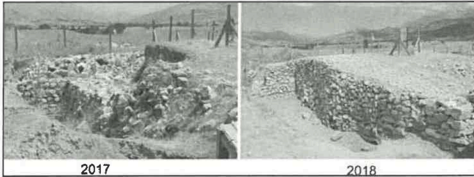
Resim 2: Porsuk-Zeyve Höyük Chantier II duvar iyileştirme çalışması.
