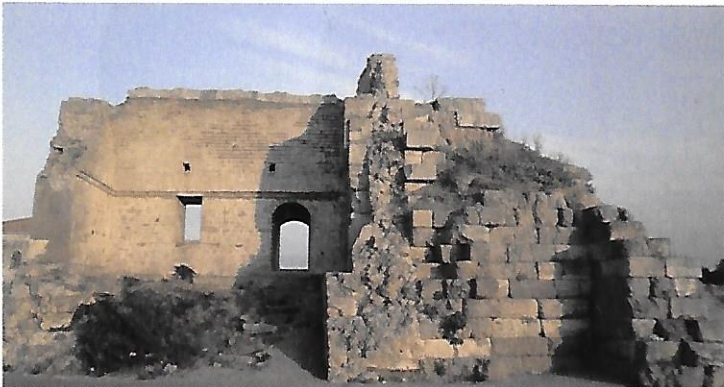
Su Kemerleri Karşısındaki Sarnıç Cistern against the aqueduct
