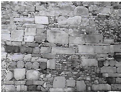
Sur yapısının Geç Roma Döneminde yeniden yapılandırılması (sütunlar, sütun başlıkları, altlıklar) Late Roman reconstruction of the fortifications (columns, capitals, bases)
