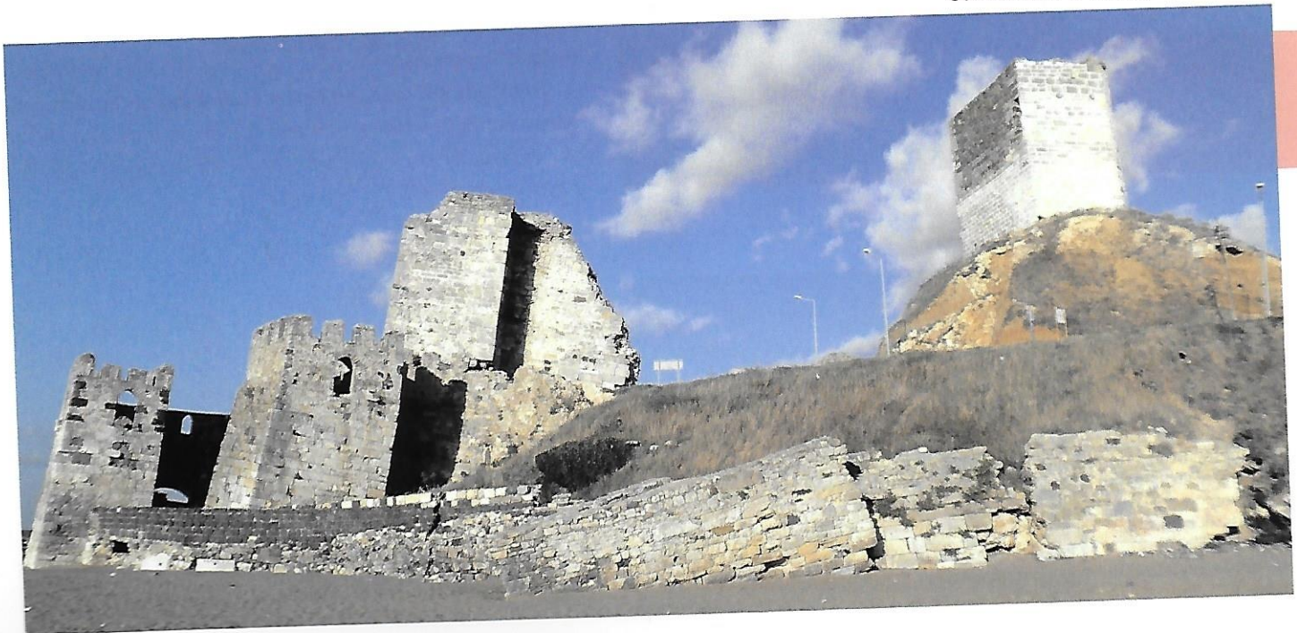
Kumkapı Genel Görünümü General view of Kumkapı (Sand Gate)
