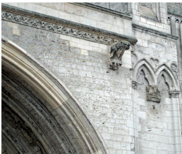
FIG. 13. — *Partie supérieure du portail méridional. Écoinçon de droite, fermé par un appareil de pierre blanche, probablement vers le milieu du xv<sup>e</sup> s.*
