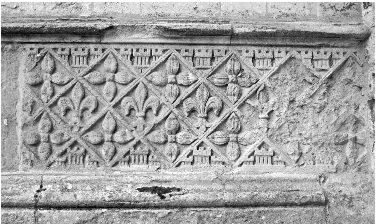
FIG. 7. — Bandeau gaufré du soubassement du portail méridional de Saint-Omer, deuxième moitié du XIII e s. Ce vestige, le seul conservé à titre de témoin, est localisé sur le retour du contrefort du côté est. © L. Nys.
