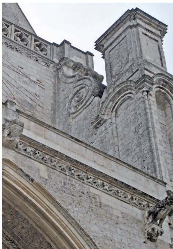
FIG. 14. — Partie supérieure de la façade du croisillon du transept sud. Pinnacle de droite et son raccord avec volute au plan supérieur de façade.
