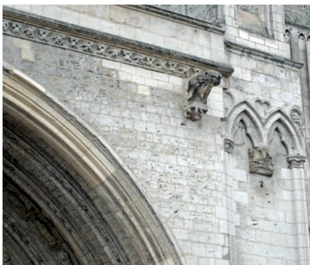
FIG. 13. — Partie supérieure du portail méridional. Écoinçon de droite, fermé par un appareil de pierre blanche, probablement vers le milieu du xv e s.
