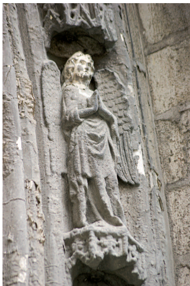
FIG. 38. — Saint-Omer, église du Saint-Sépulcre, portail latéral sud. Statuette d'ange à la voussure, ca 1380. La tête, brisée, a été remastiquée en plâtre. © M. Lekane.
