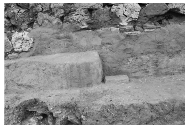
Baquette de briques et enduit contre le mur M2
