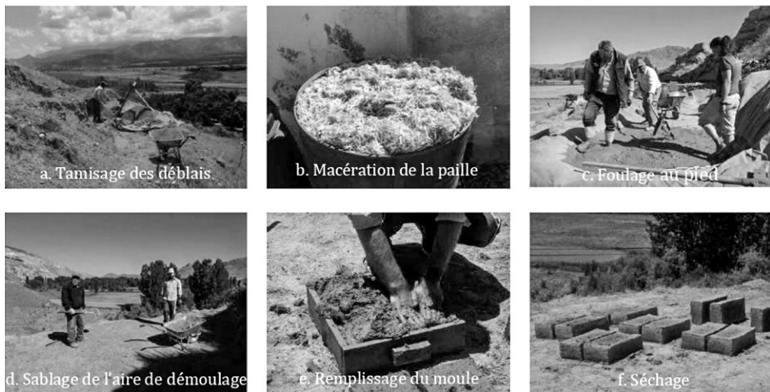
Fig. 28 Étapes de la production de briques crues 2022
