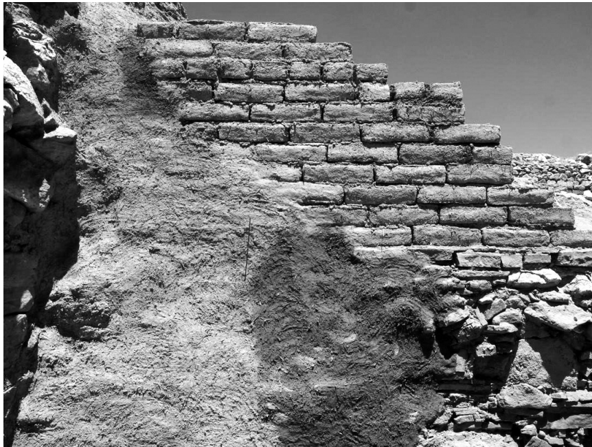
Fig. 36 Conservation avec enduit sacrificiel dans le couloir coudé (© CRAterre_ C. Sadozai 2022).
