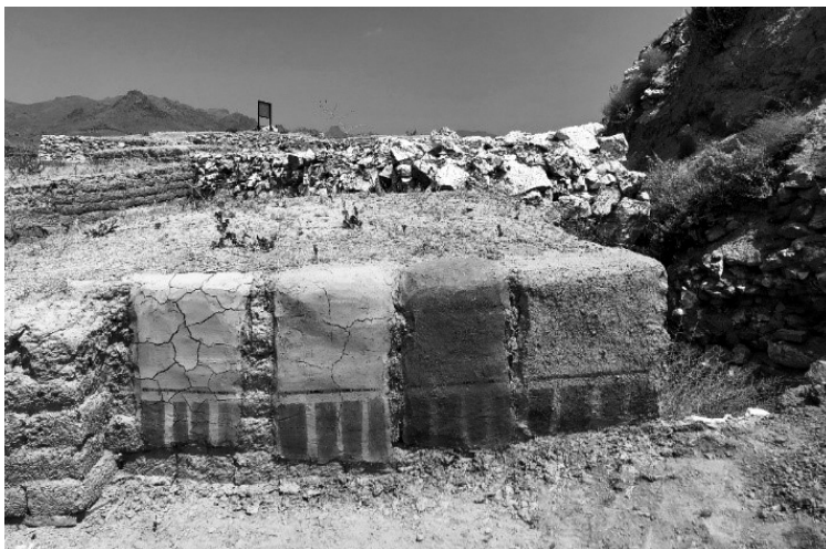
Fig. 38 Vue des tests Paraloid sur les tests d'enduits. (© Louise Bruneau).
