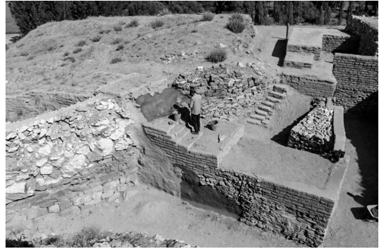
Fig. 32 Pose d'enduit sacrificiel sur la partie sommitale du mur du couloir coudé (© Mission archéologique de Porsuk – Zeyve Höyük).
