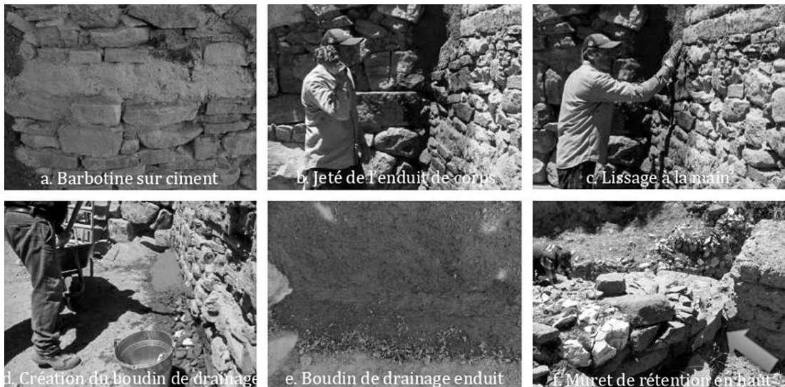
Fig. 37 Étapes de conservation par pose d'un enduit sacrificiel [© CRAterre_C. Sadozai 2022 (a--d--e--f) / Mission Porsuk--Zeyve Höyük (b--c)].
