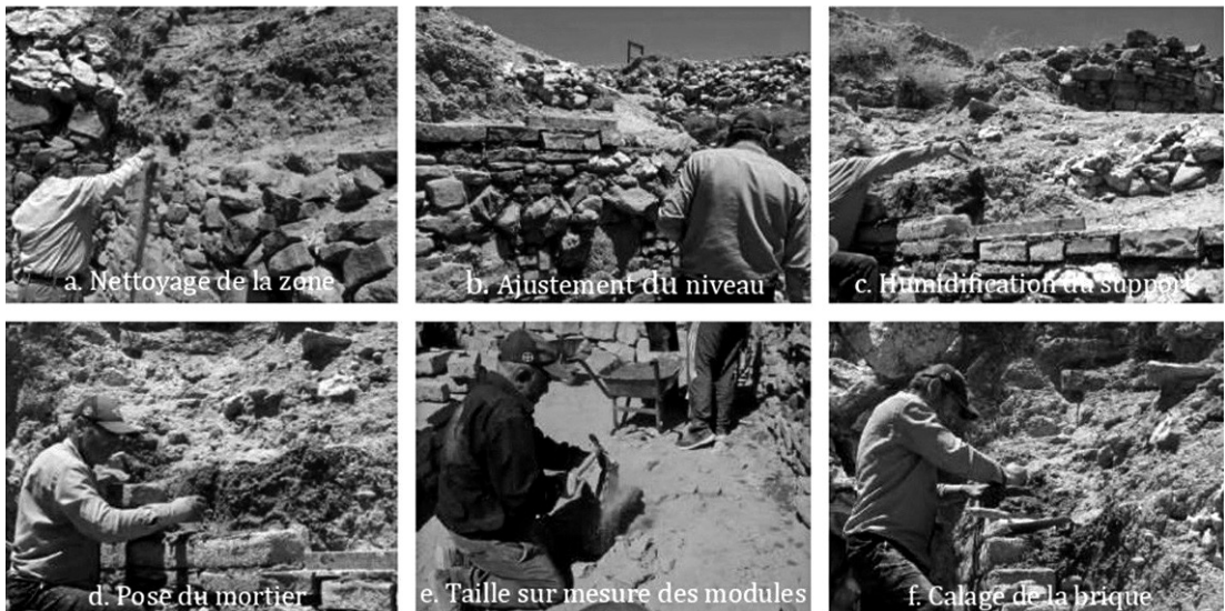
Fig. 33 Étapes de la conservation par enveloppe (© CRAterre_C. Sadozaï 2022).
