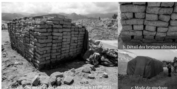
Fig. 27 Briques produites sur le site en 2021 et 2019 (© CRATerre_C. Sadozaï 2022).
