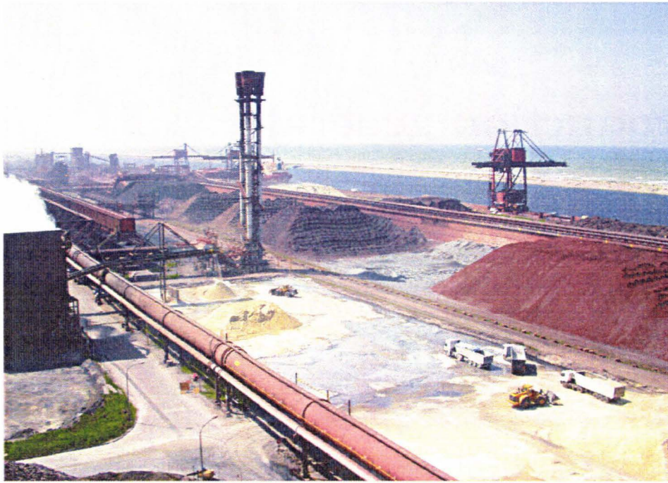
Figure 1 – Zone de stockage de matières granulaires sur le site d'ArcelorMittal
