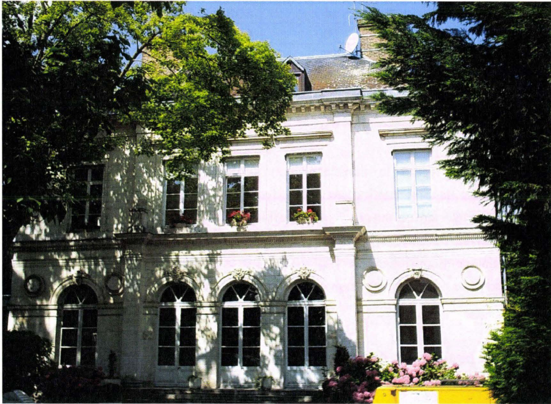
Illustration 10: Vue actuelle de la façade arrière.
