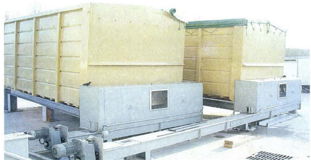
(b) Silos de stockage biomasse
