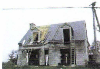
8 = pose des tuiles
