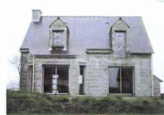
9 = pose des fenêtres
