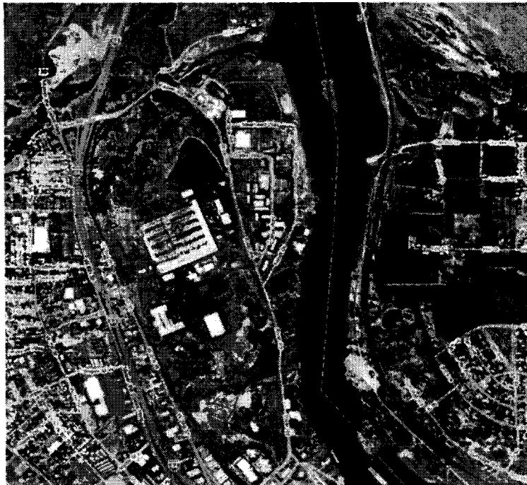
Figure 54 – Image satellite de l'emplacement du prochain centre de calcul en cours de construction que Google ouvrira en Oregon – USA – jouxtant la rivière Columbia séparant l'état de l'Oregon de Washington (en noir au centre de l'image). Cet emplacement stratégique permet au centre de calculs d'acheter son énergie électrique très bon marché car produite sur place. Source : Google Maps.
