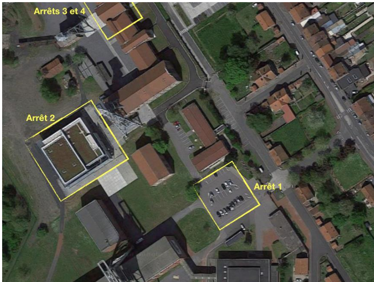
Figure 25 : Plan des arrêts du parcours patrimonial évolutif sur le site Arenberg Creative Mine.
