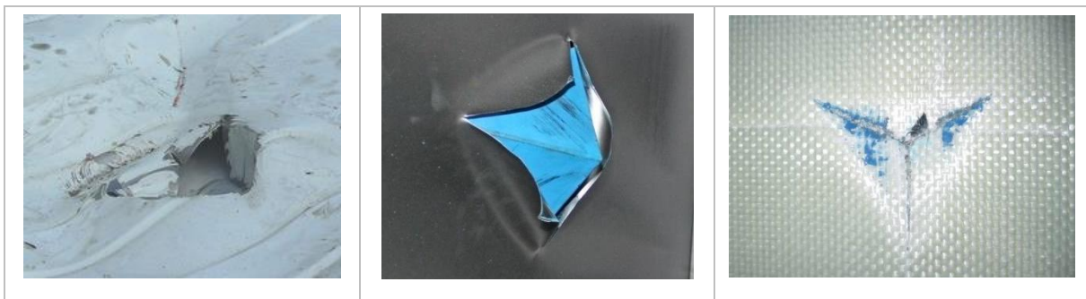
Figure 50: Exemple de fissuration et ruptures
